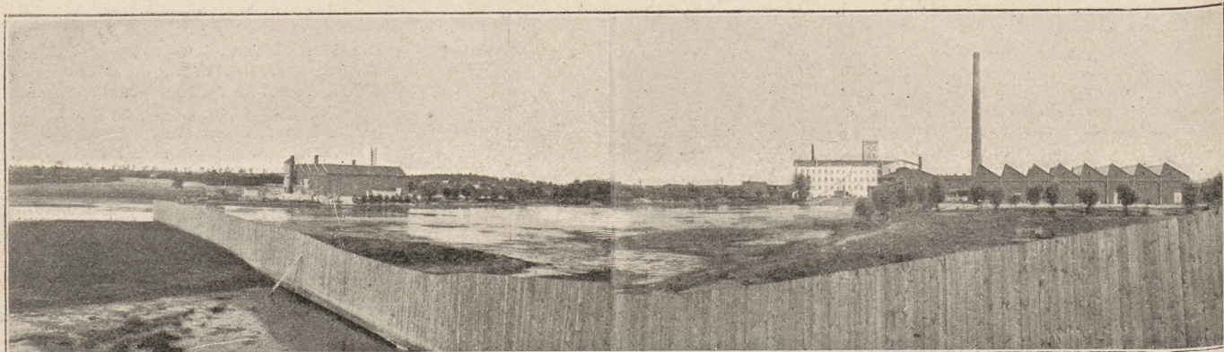
Ogólny widok (panorama) fabryki sztucznego jedwabiu w Wilanowie.
