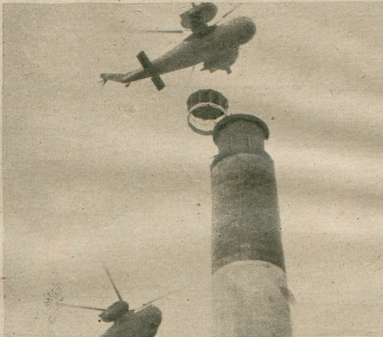
Na szczycie latarni morskiej w Oak Island trzeba było ustawić dodatkową lampownię. Pomysłowi Amerykanie posłużyli się helikopterem, który sprawnie ustawił nadbudówkę ważącą 1740 funtów w żądanym miejscu. (CAF)
