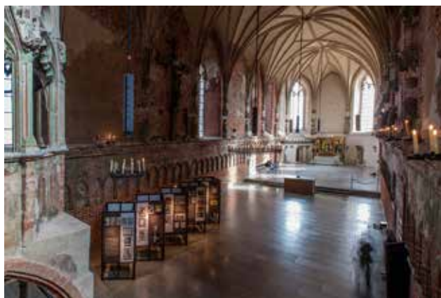
Wnętrze kościoła zamkowego w Malborku po zakończeniu prac (2016), widok w kierunku ptn.-wsch., fot. Damian Kwiecień
