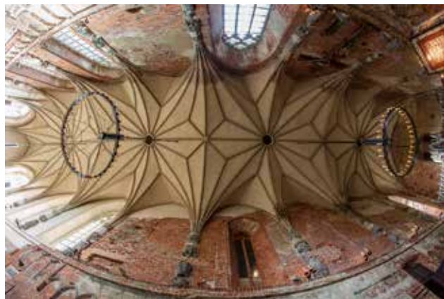
Wnętrze kościoła zamkowego w Malborku po zakończeniu prac (2016), widok na sklepienie, fot. Damian Kwiecień
