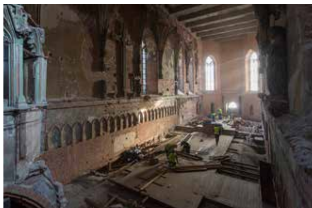
Wnętrze kościoła zamkowego w Malborku przed rozpoczęciem projektu (2014), widok w kierunku ptn.-wsch., fot. Damian Kwiecień
