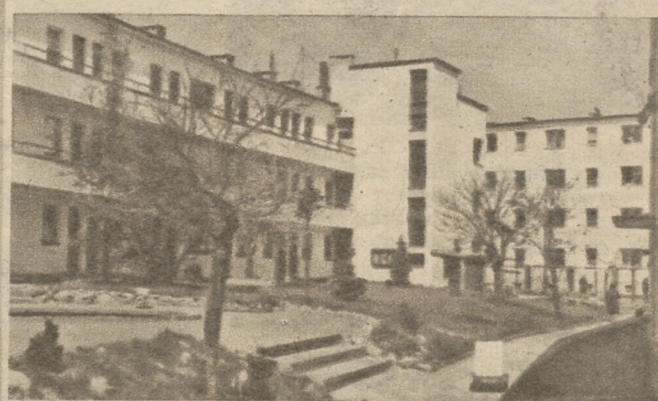
Milionowa ludność robotnicza Warszawy mieszkać będzie w nowoczesnych pięknych domach. Plan 6-letni przewiduje budowę nowych 128.000 izb mieszkalnych
