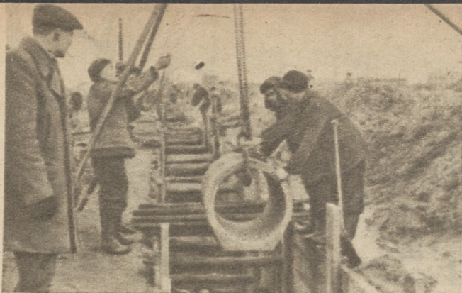
Naprawa sieci elektrycznej, gazowej i wodociągowej stanowiła najpilniejszą pracę, jaką trzeba było wykonać dla przywrócenia Warszawy do życia
