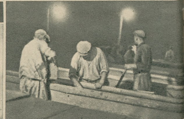
Praca prowadzona była na dwie zmiany. Oto trójka murarska w świetle reflektorów, zajęta układaniem dachu
