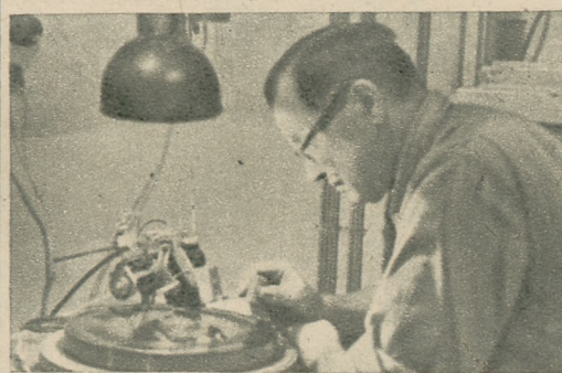
Głos mówcy przechodzi przez mikrofon do amplifikatorów, które przesyłają go do utrwalenia na płycie woskowej. Kierownik Kołakowski kontroluje działanie aparatury do nagrywania
