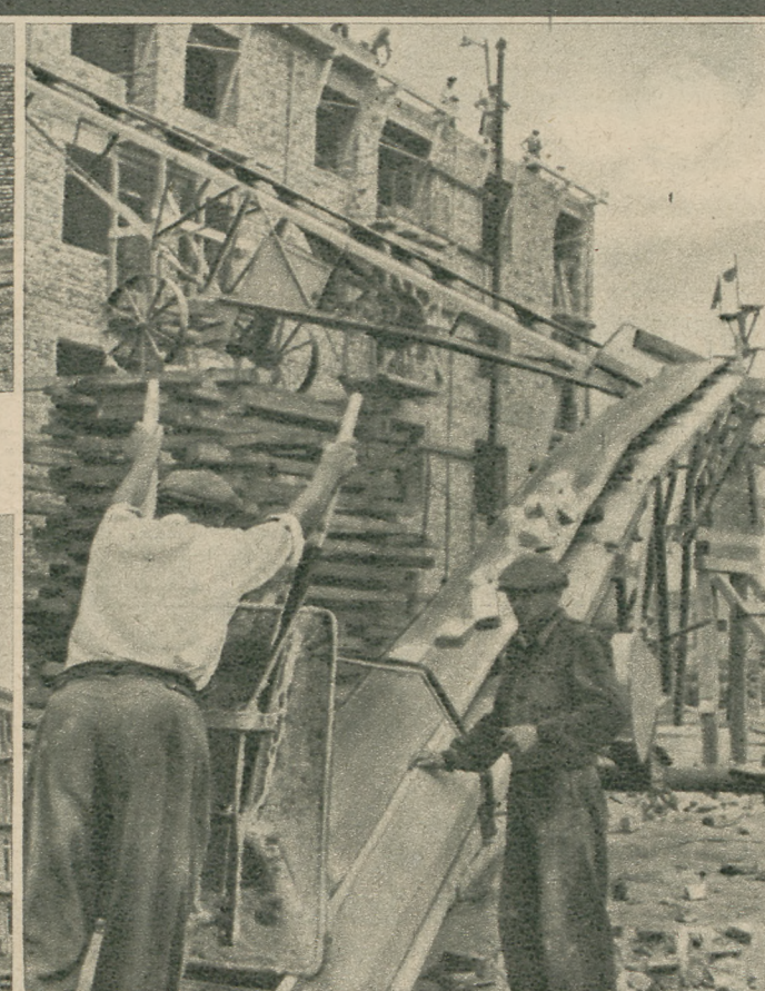
Wyniki te osiągnięto dzięki organizacji pracy i daleko posuniętej mechanizacji. Na zdjęciu: transportery, podające cegły na piętra
