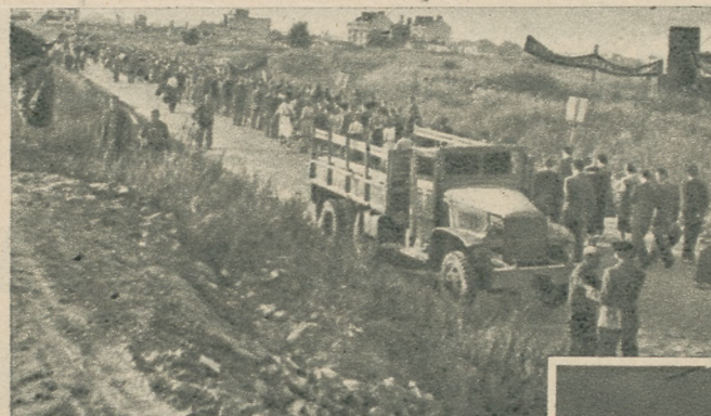
Wrzesień — miesiącem odbudowy Warszawy. W odbudowie biorą udział tysiące ochotników. Na zdjęciu: wymarsz ochotników do pracy przy budowie Nowej Marszałkowskiej
