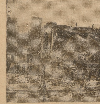
Dni wiaduktów Pancera są już połączono. Rozbija go i materiał wybuchowy, i maszyny i ludzie.
