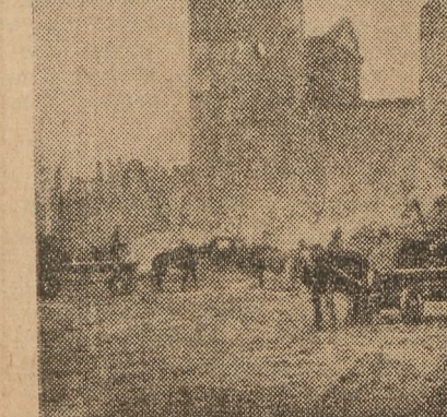
Tu, na rogu Miodowej i Kapturowej, będzie się wjeżdżało do tunełu. Teren już oczyszczono, można już przystąpić do kopania.
