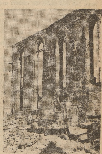
Już jest dach nad prezbiterium. Już odbudowano ścianę od Dziekanii i dwi. kaplice. W tej chwili wznosi się ścianę od strony Jezuitów.
