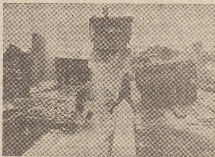
Rozładunek transportów z burakami znakomicie przyspieszają rampy wyposażone w urządzenia hydrauliczne.
