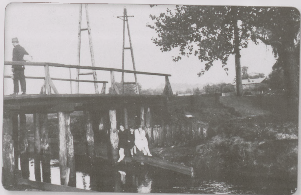
Drewniany most na Utracie między Gąsinem a Żbikowem (okolice terenu elektrowni)
