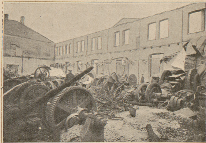
Remiza parowozów przedstawia obecnie rumowisko potrzaskanych kół, osi i metalowych części, których ogień nie strawił.
