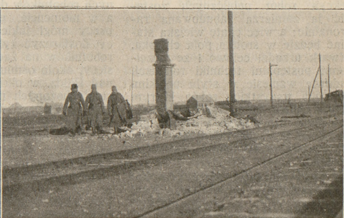
Ruiny wodociągów na stacji kolejowej.
