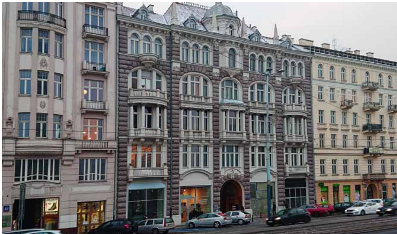
Nie tylko reprivatyzacja była zmartwieniem mieszkańców, ale i bardzo zły stan techniczny budynku.
