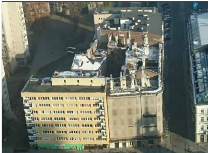
Listopad 2016 r. – dach budynku Próżna 14 w trakcie nakazanych przez konserwatora prac remontowych. Wcześniej rozebrano grożącą katastrofą konstrukcję, z powodu roszczeń nie remontowaną latami.
