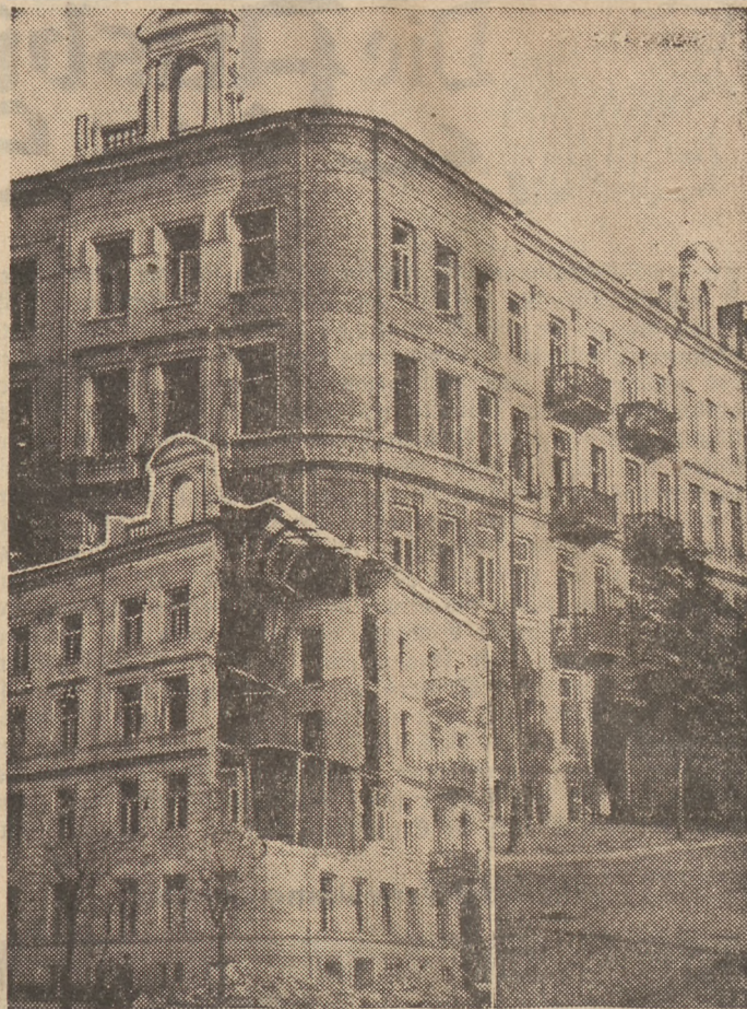
Ein durch Bombentreffer beschädigtes Haus früherer militärischer Bedeutung vor und nach vierwöchiger Wiederherstellung
