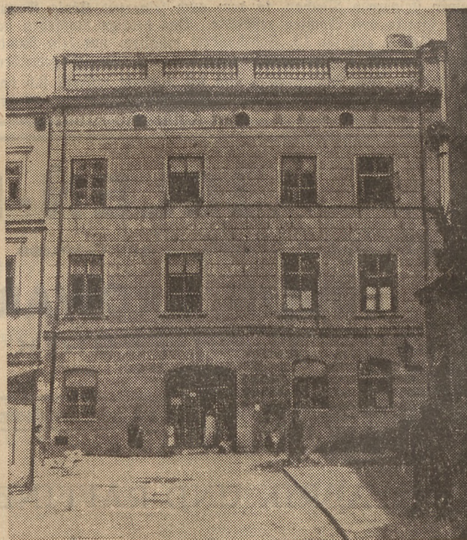
Das Haus Alter Markt 8 in der Lubliner Altstadt. Darunter der alte deutsche Weinkeller aus dem Jahre 1570
