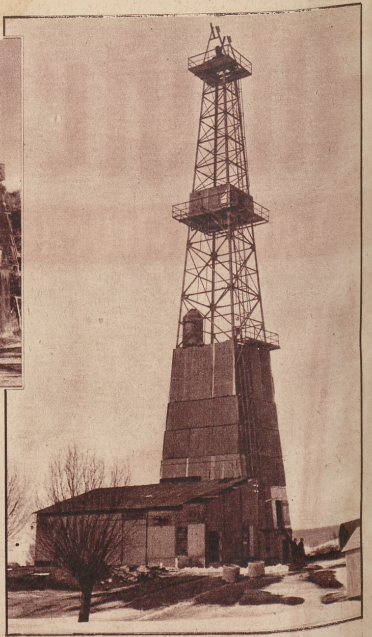
Einer der ersten von Deutschen erbauten Bohrtürme bei Jaslo.
