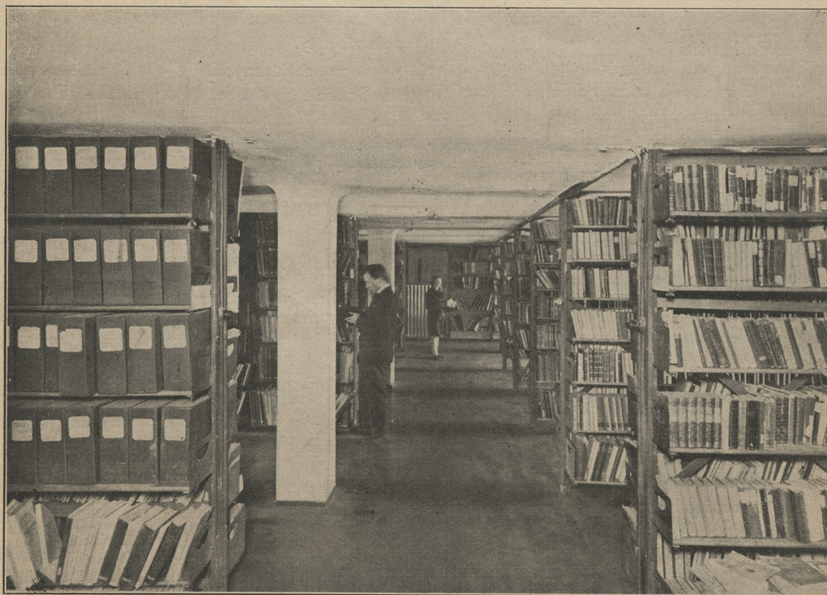
Magazyny książkowe Biblioteki Publicznej m. st. Warszawy.
