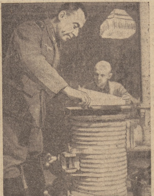
Bunkerleben an der Kanalfront: Gassichere Öfen in bombensicheren Mannschaftsräumen sorgen mit Entlüftungsanlagen für gesunde Aufenthaltsbedingungen.
