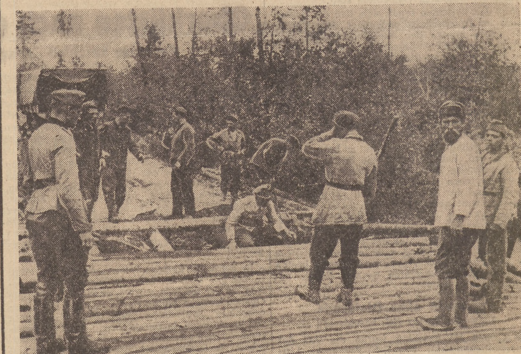
Freiwillige Landeseinwohner beim Bau eines Knüppeldammes im Sumpfwald des Ilmensees.
