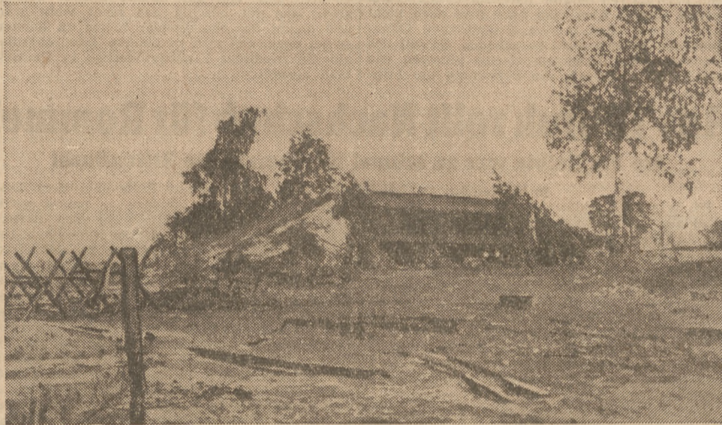
Die Stalin-Linie verfügte über eine große Zahl modernster, zum Teil raffiniert getarnter Bunker, die trotzdem dem deutschen Ansturm nicht standhielten. Aufn.: Archiv
