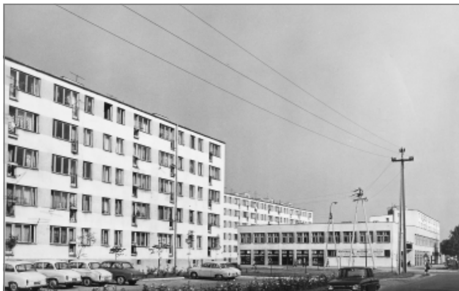
Blok mieszkalny i budynek RSM „Ursus” przy ul. Wawelskiej (dziś ul. Sosnkowskiego) wybudowane na ziemi należącej ongiś do Wallów – pocztówka z połowy lat 70.
