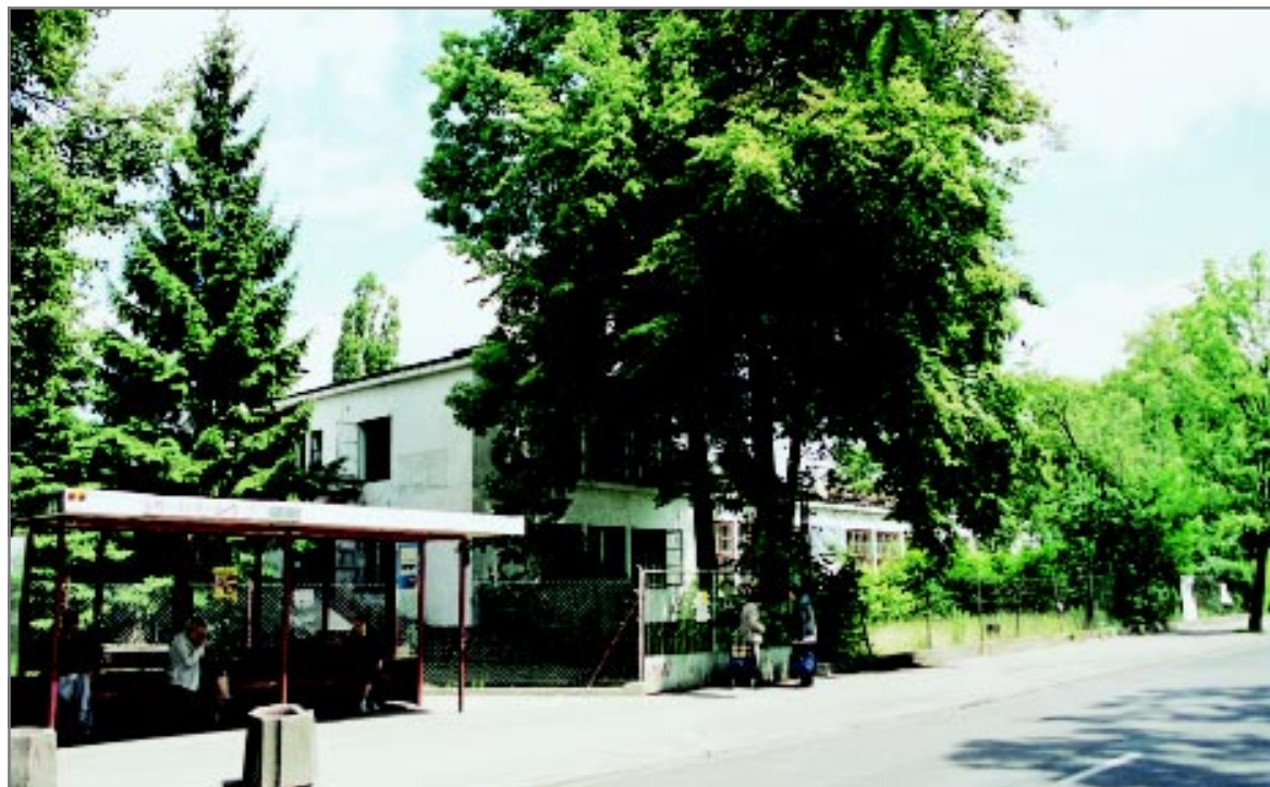
Dawny budynek „jedynki” tuż przed rozbiórką latem 2001 roku. Kiedyś na parterze mieściły się klasy, na piętrze mieszkał Śliski.
