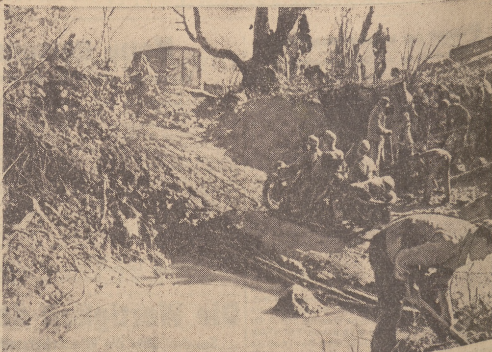
Während die Pioniere mit der Wiederherstellung einer zerstörten Brücke beschäftigt sind, rollt an ihnen vorbei der Nachschub in ununterbrochener Folge über einen Behelfssteg.
