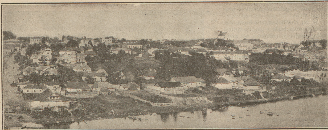
Widok od strony południowej.
