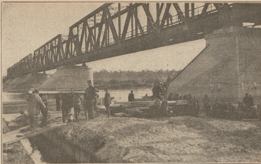
Most kolejowy na rzece Bug zniszczony.
