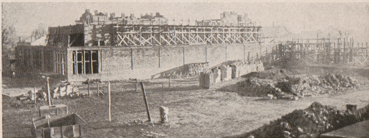
Budowa kina przy ul. Leszno. Listopad 1948 r.
