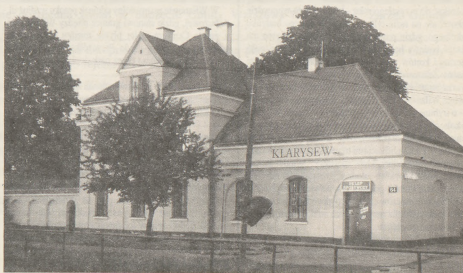
Podobnie jak budynek poczty w Wilanowie, który swego czasu był stacją „ciuchci” (o kolejce wilanowskiej pisaliśmy w nr 10 „Biuletynu”), drugą pamiątką po tym popularnym niegdyś środku komunikacji jest budynek stacyjny w Klarysewie — tuż za granicą naszej gminy, w gminie Konstancin-Jeziorna, przy ul. Warszawskiej.
