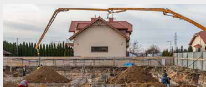
Plac budowy żłobka przy ul. H. Pobożnego
