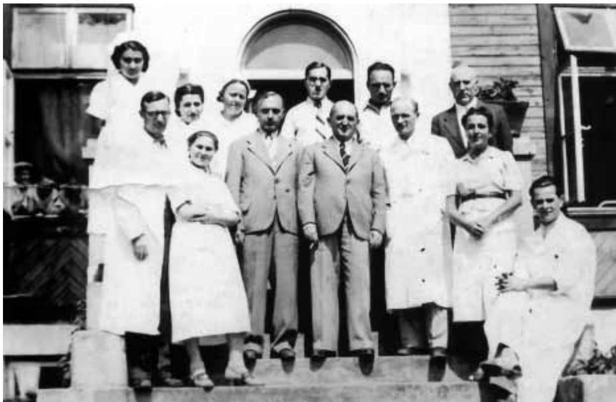
Zespół lekarsko-pielęgniarski „Marpe” - zdjęcie zrobiono w czasie odbioru nowo wybudowanego budynku z bieżącą wodą, wannami i prysznicami (dziś już nie istnieje)
