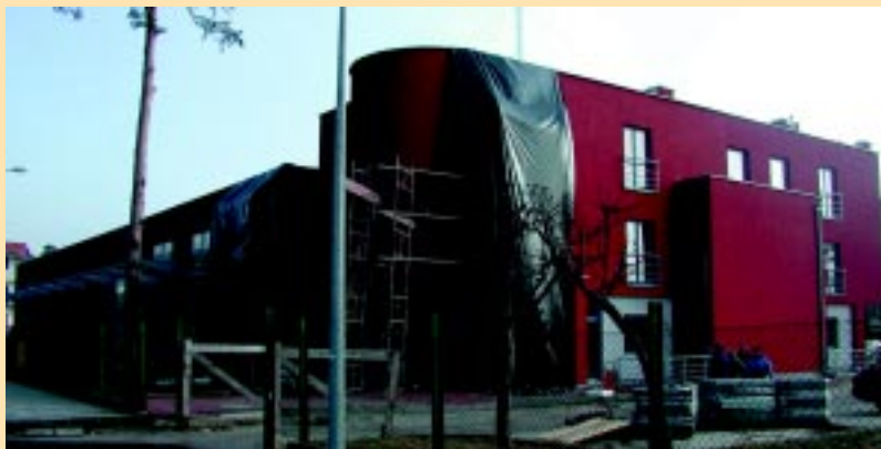
Dobiega końca budowa nowej siedziby Straży Pożarnej przy ul. Mieszka I
