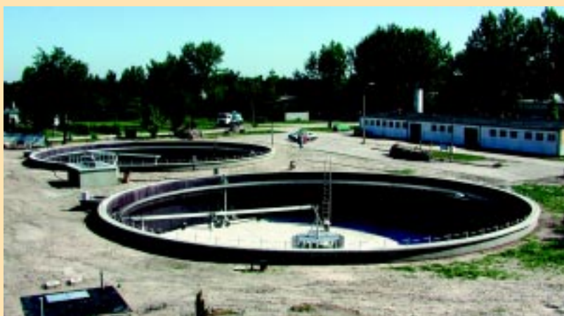
Wielomilionowa inwestycja Otwocka - modernizacja oczyszczalni ścieków
