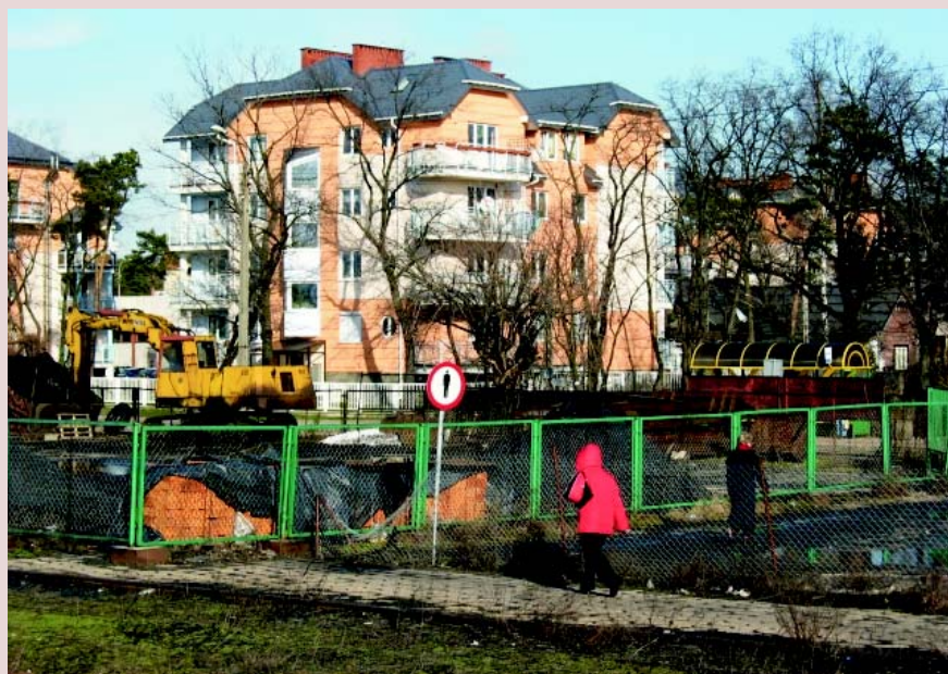
Przejście między składem węgla a stacją gazu
