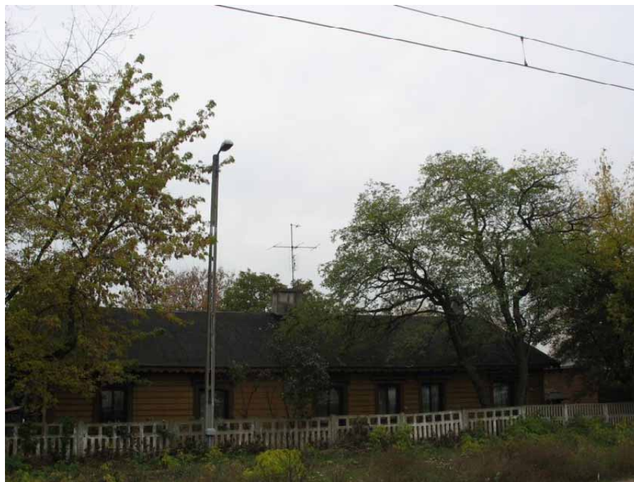
Dawny budynek mieszkalny dla kolejarzy
