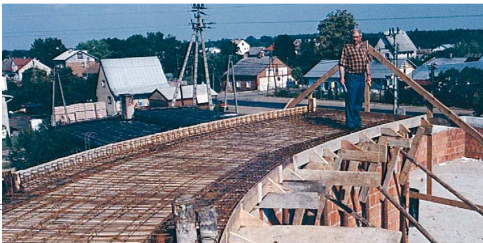
Pan Eugeniusz nadzorujący budowę Urzędu Gminy w Kołbieli
