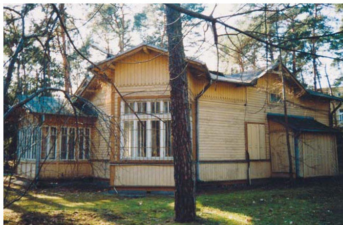
Budynek przy ulicy Prusa 1/3
