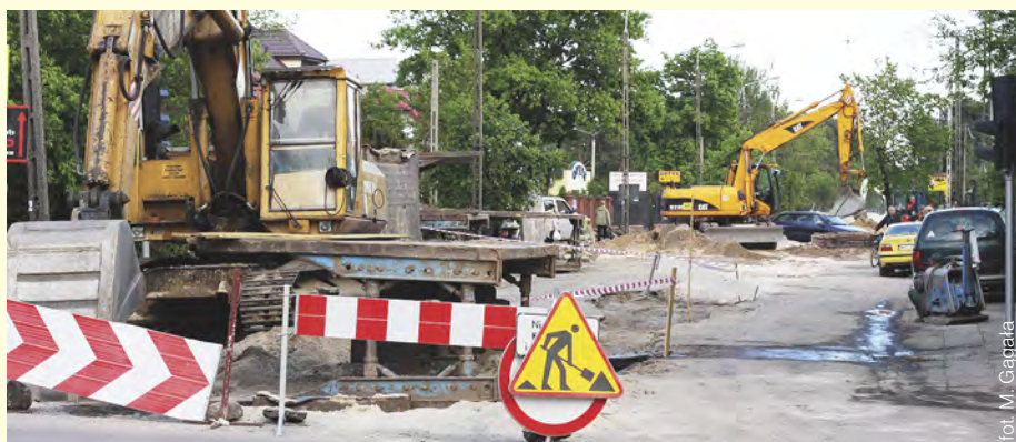
Budowa instalacji wodociągowo-kanalizacyjnej w ulicy Kołłątaja rozpoczęta. Pomimo opóźnienia prac budowlanych, wykonawcy robót i nadzorująca prace Jednostka Realizująca Projekt zapowiadają ich zakończenie w pierwotnym terminie – 18 maja.
