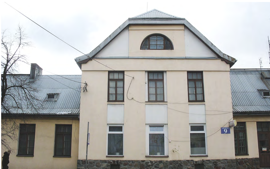
Budynek kolejowej stacji Otwock
