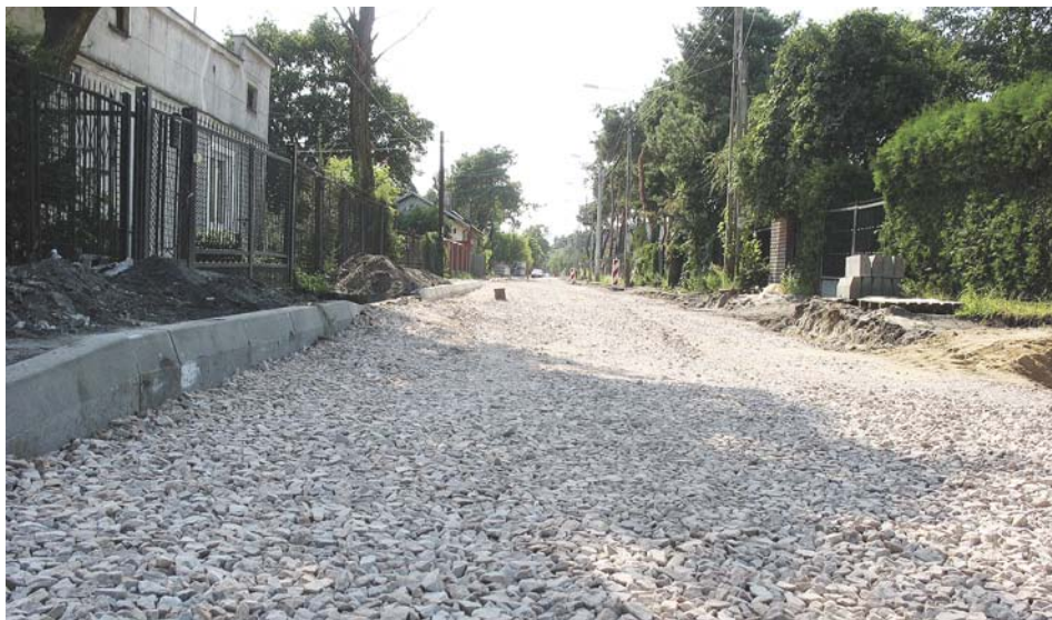
Podbudowa z tłuczni na ul. Jodłowej
