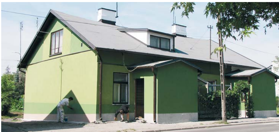
Budynek przy ul. Staszica 4 po remoncie
