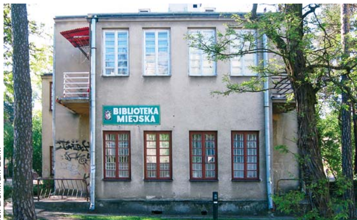
Bydynek przy ul. Andriollego 42 przed remontem
