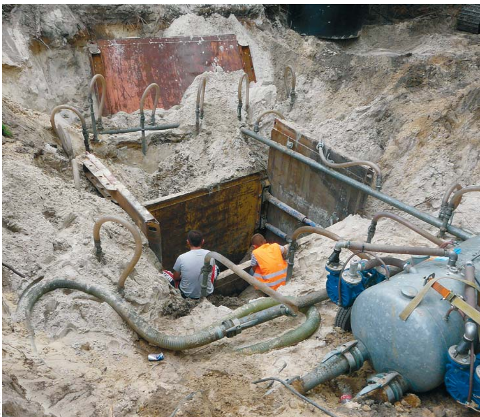
Deszczowe lato i wysoki poziom wód gruntowych w niektórych miejscach miasta zmusiły wykonawców Projektu do użycia specjalnych pomp odwodnieniowych
