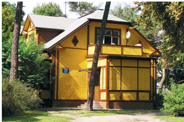
Bydynek przy ul. Poniatowskiego 13 po remoncie
