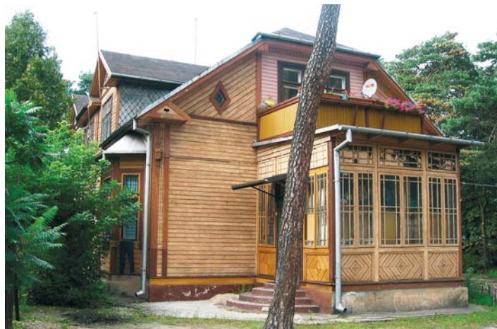
Bydynek przy ul. Poniatowskiego 13 przed remontem
