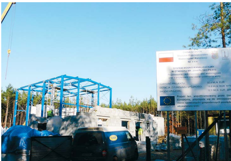
Nowobudowana Stacja przy ul. Grunwaldzkiej
