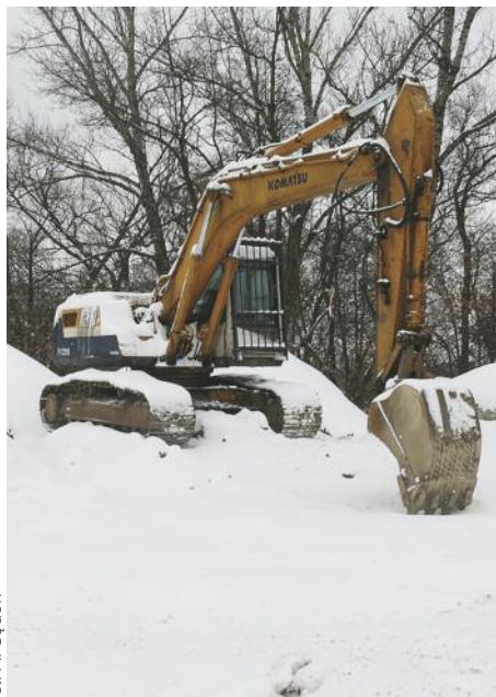
Prace porządkowe przy ul. Wypoczynkowej
