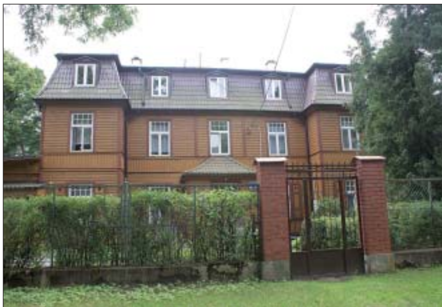
Budynek przedwojennego pensjonatu Eden przy ul. Konopnickiej
