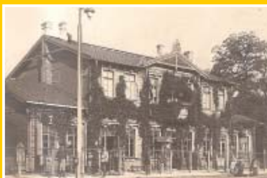
Dworzec kolejowy w Otwocku pod koniec XIX w.
