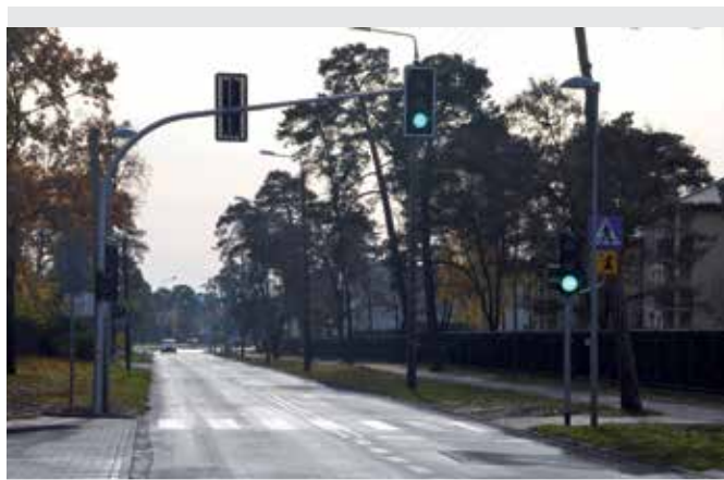
Sygnalizacja świetlna w ulicy Kraszewskiego
