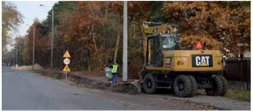
Ciąg pieszo-rowerowy w ul. Żeromskiego
