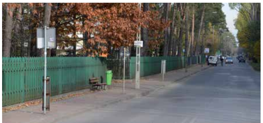
Chodnik w ul. Narutowicza przed planowaną modernizacją
