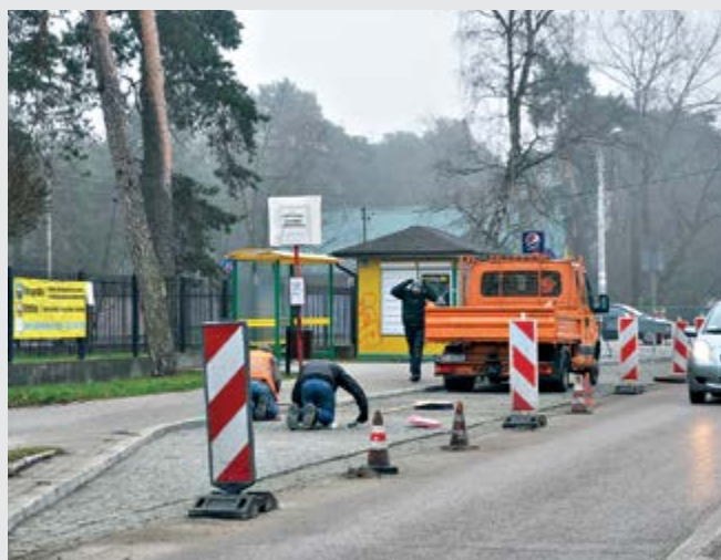
Zatoka przystankowa przy ul. Andriollego (przy rondzie)
