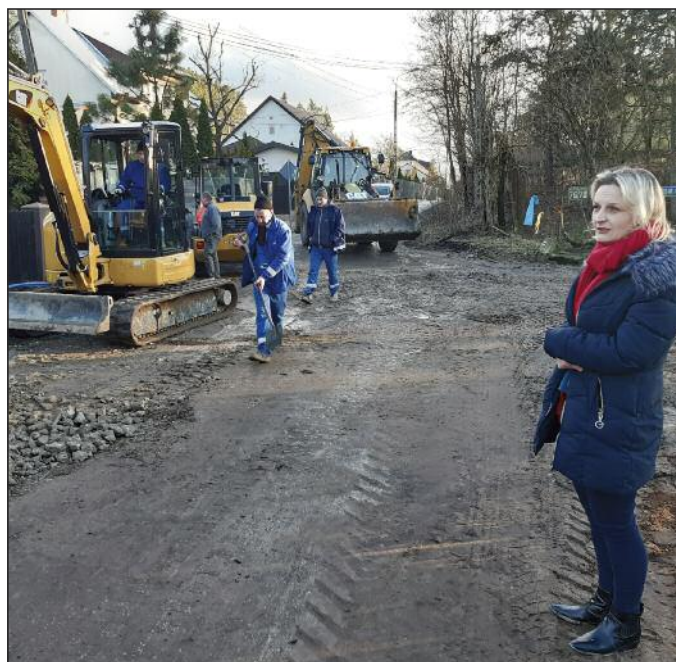
Prace kanalizacyjne na ul. Osieckiej
