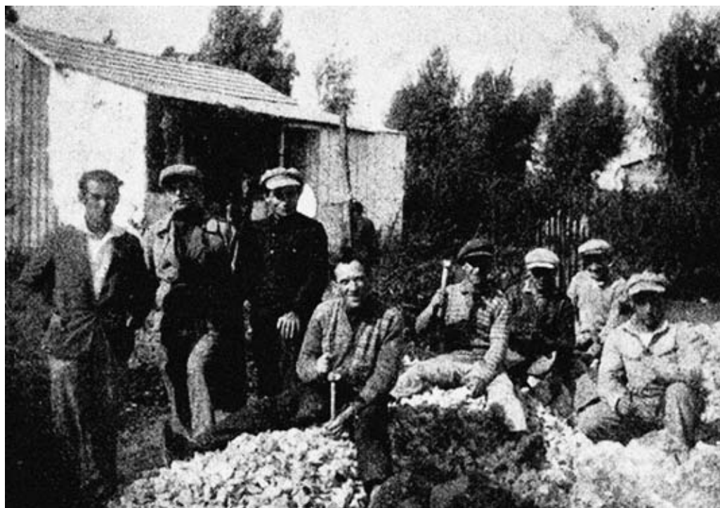
45. Członkowie grupy „Jechideja” pracują przy budowie drogi w Palestynie
