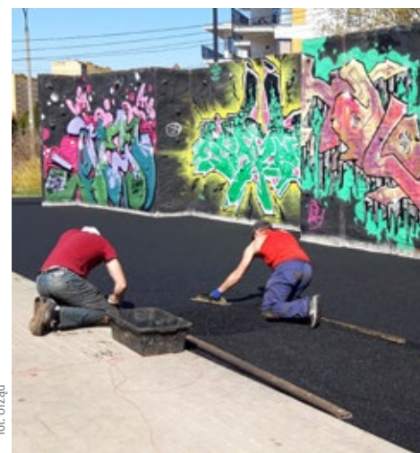
Wymiana nawierzchni na placu zabaw „Hasanka”
