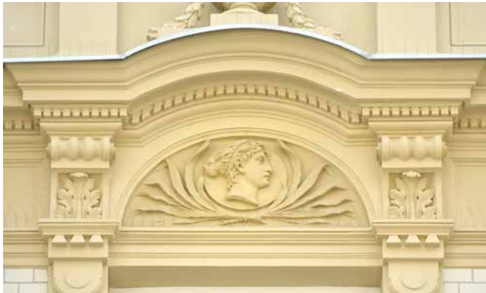
Detale architektoniczne zostały oczyszczone i poddane pracom konserwatorskim
