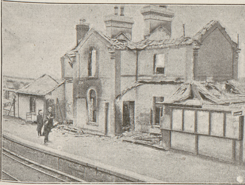
Zniszczona przez republikanów stacja kolejowa w Kilmessan.
