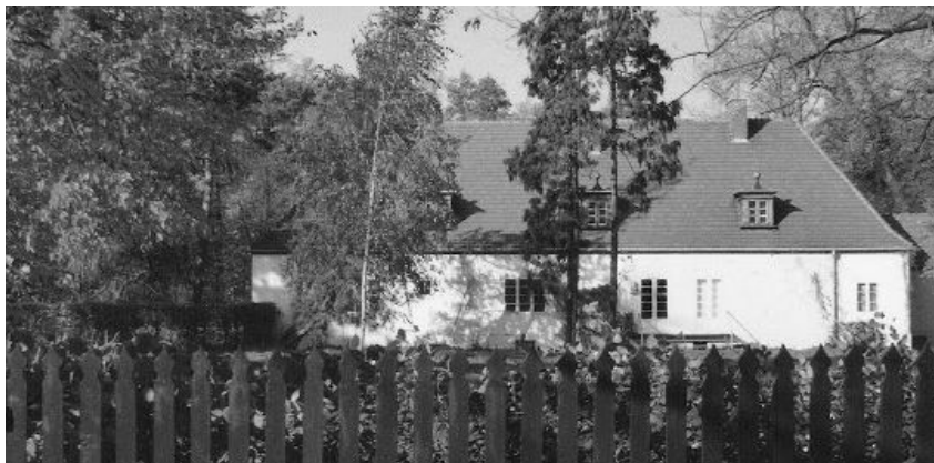
Dwór w Manach kilka lat temu (przed rozbiórką).
