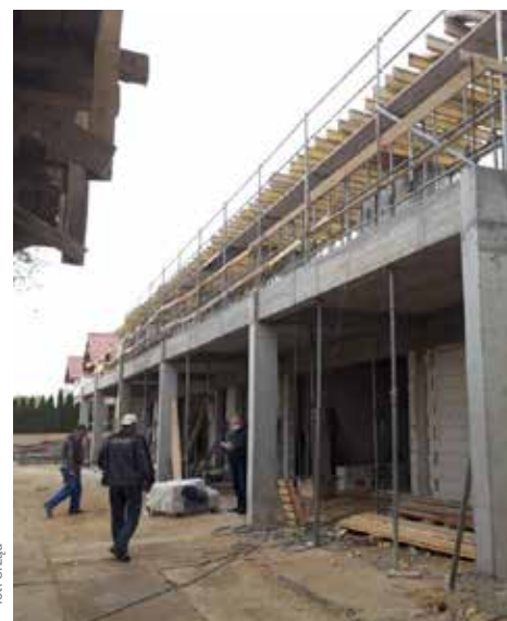
Żłobek przy ul. Henryka Pobożnego – budowa konstrukcji stropodachu
