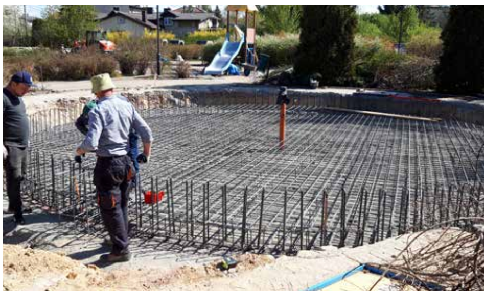
Budowa wodnego placu zabaw „Hasanka”
