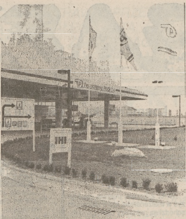
Stacja paliw Petrochemii na granicy "Zielonego Jaru" Fot. St. Bąkiewicz
