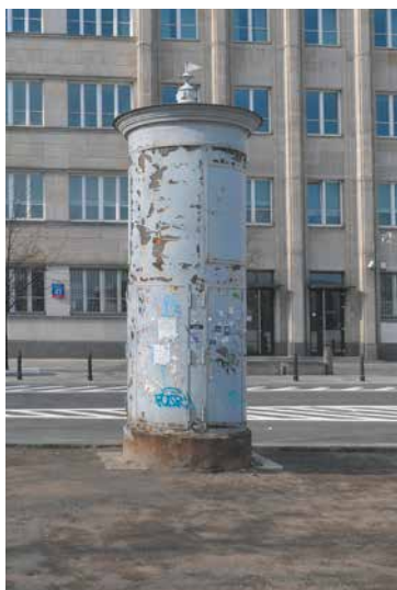
Stacja transformatorowa w formie kiosku pochodząca z początku XX w., umożliwiająca przesyłanie energii z Elektrowni Powiśle do warszawskich kamienic
