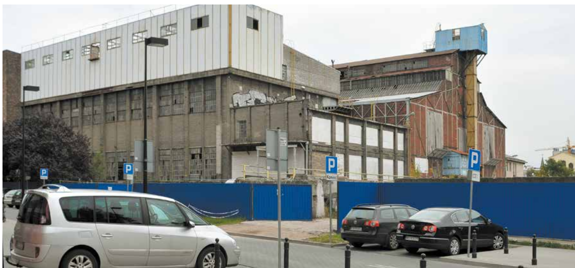
Widok na Kotłownię nr II, Kotłownię nr III w 2011 r.
