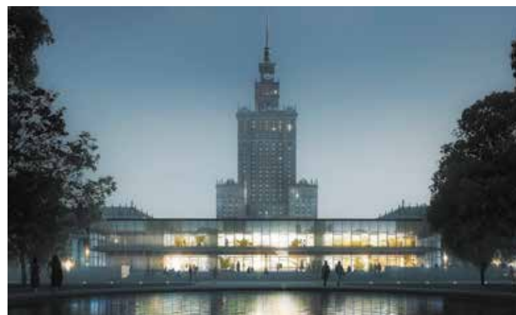
Realizację inwestycji zaplanowano w formule PPP
