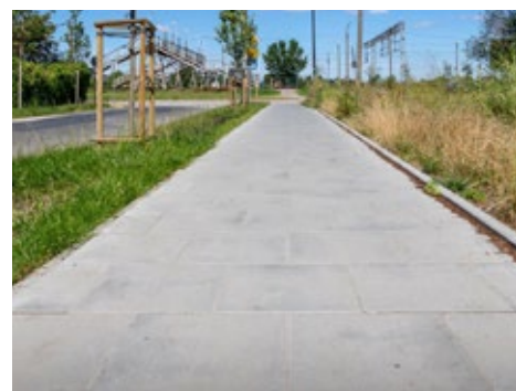
Wyremontowany chodnik na ul. W. Kadłubka
