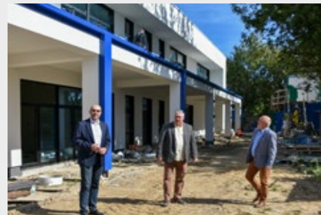
Budowa żłobka przy ul. H. Pobożnego
