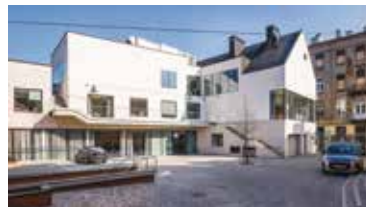
Widok budynku C od strony dziedzińca muzealnego, fot. Jakub Certowicz
