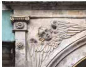
Detal kamienny, stan przed renowacją
