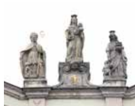
Rzeźby w attyce kamienicy nr 28, stan przed renowacją
