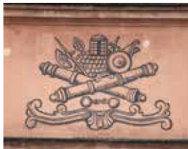
Detale zachowania sgrafitta i tynków gładkich, stan przed renowacją
