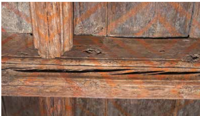
Detal polichromii III stropu, fot. Kana
